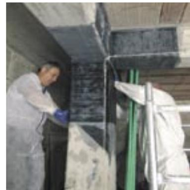
5 - Posa dei vari strati di fibra e ulteriore stesura di resina a completamento del ciclo.
