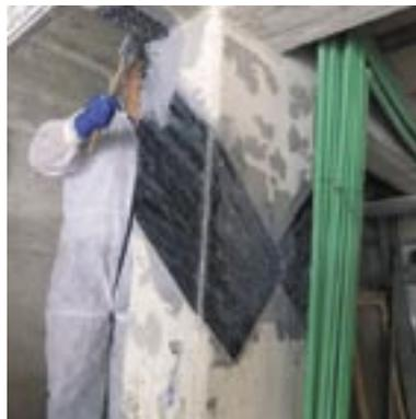
4 - Stesura della resina e posa dei vari strati di fibre
