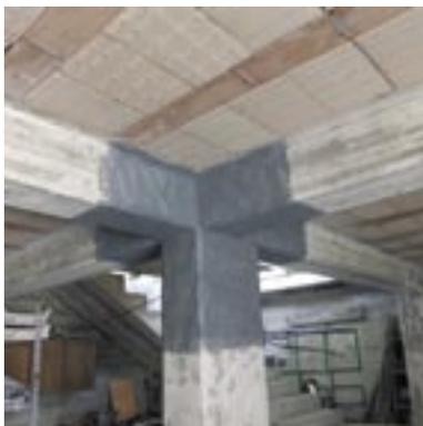
6 - Completamento intervento con stesura di sabbia silicea per favorire l'adesione del successivo strato di intonaco.
