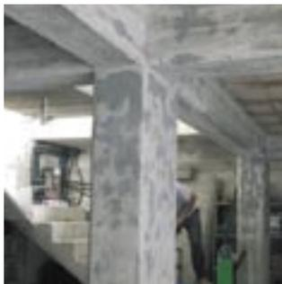
2 - Preparazione delle superfici alla posa delle fibre, consistente nel ripristino delle parti ammalorate mediante il preventivo trattamento dei ferri di armatura con idonei passivanti e successiva ricostruzione con malte tixotropiche, ulteriore stuccatura con appositi adesivi epossidici anche delle minime incoerenze, levigatura dell'intera superficie e stonatura degli spigoli.
