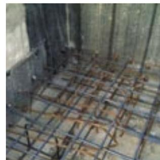
*Impermeabilizzazione con teli bentonitici di piano interrato sotto falda*
