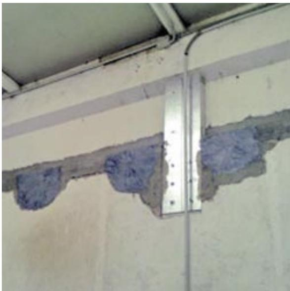
3- Apertura del fiocco in carbonio, impregnatura con resine epossidiche e successiva intonacatura a chiusura dell'intervento.
